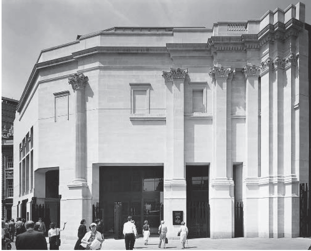
شكل ٤-٨: جناح سينسبري في المعرض الوطني بلندن (١٩٩١)، تصميم فينتوري، مؤسسة سكوت براون أند أسوشيتس. (مبنى جديد، يحاكي أساليب معمارية أقدم. أي محاكاة ساخرة؟)
